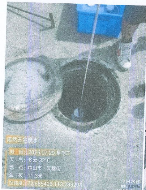
生活污水排放口
