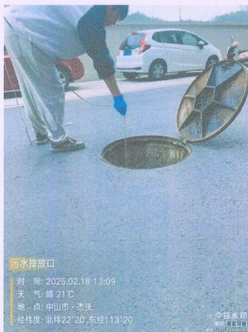
生活污水排放口
